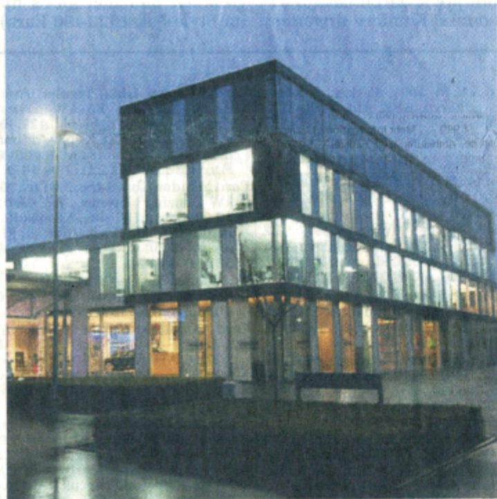
Das Senger-Verwaltungsgebäude wurde in einer Bauzeit von 9 Monaten mit einer Investitionssumme von 1 Millionen Euro um zwei Etagen aufgestockt.
